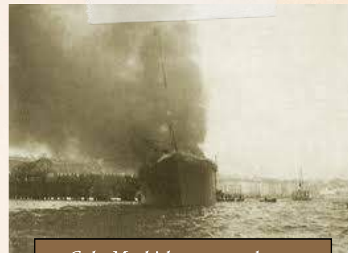
Cabo Machichaco atracado en Santander durante el incendio
